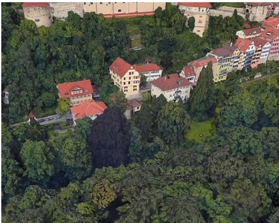
Dekanat (hinter der Rotbuche)
